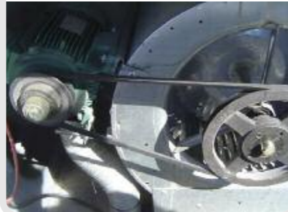
Photo 2 : Courroie ventilateur en bon état
