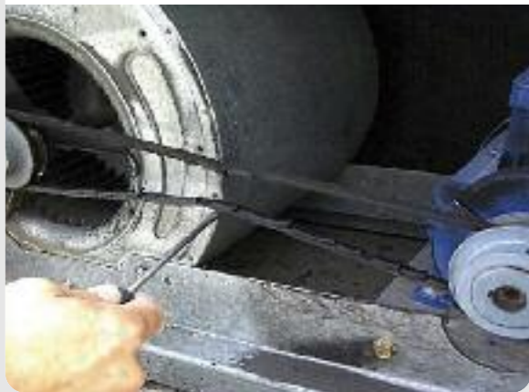
Photo 3 : Courroie ventilateur en mauvais état
