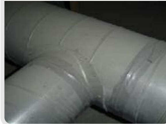
Photo 5 : Conduits étanches en combles
