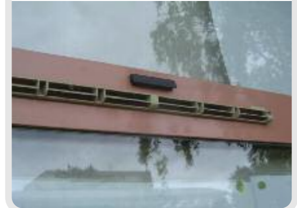
Photo 8 : Entrée d'air dans une fenêtre
