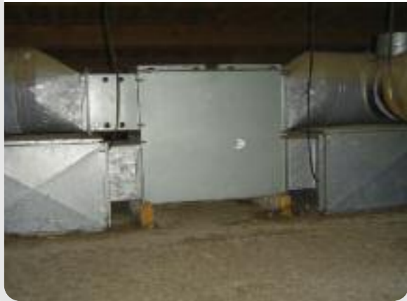
Photo 1 : Centrale double flux dans des combles
